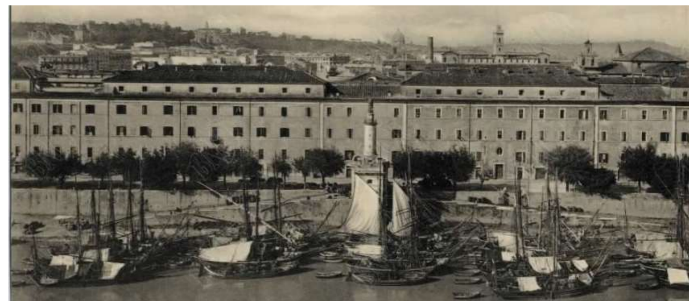
Le prime baracche installate a Via Portuense
